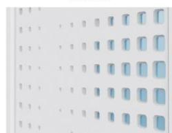
Oluşturulan örgüdeki dörtgenler CNC yöntemiyle deliklere dönüşüyor. Bu konik deliklerin iç yüzeydeki dörtgenleri, üst yüzeydeki dörtgenlerin belirli oranda küçültülmüşinden oluşuyor.
